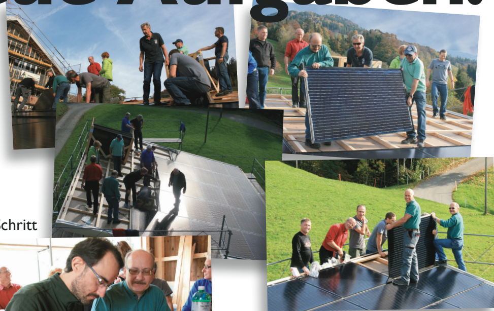
21. Oktober 2017: Impressionen von der Montage der Anlage oberhalb von Seewen. Die 40 Paneele wurden in wenigen Stunden verlegt und verkabelt. Links: Der Grundeigentümer, Armin Betschart, und der Präsident der Solargenossenschaft, Theo Steiner, beim Unterzeichnen der Nutzungsvereinbarung.
